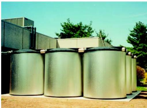
冰蓄冷中央空调是指在用电低谷时段采用电能制冰并储存在蓄冰装置中，在电网高峰时段或者需要时，再把冷量从蓄冷装置中取出来进行制冷的中央空调系统，由此来实现对电网的“削峰填谷”作用。冰蓄冷中央空调技术的推广和应用，有利于促进能源、经济和环境的协调发展，并能取得良好社会效益和经济效益。
